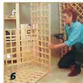
Квадратные вставки должны плотно входить в ячейки решётки-столешницы.
