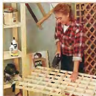
Спинку выкраивают из прямоугольного щита, отпилив лишние ячейки.
