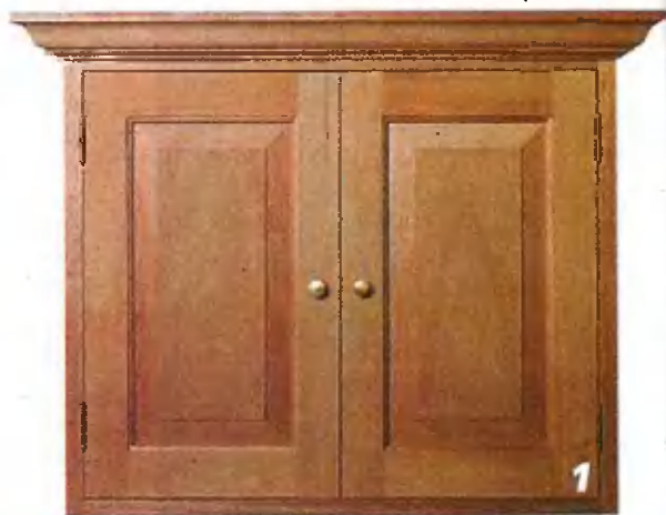
Дверцы без притвора. Такие дверцы делают, если створки должны открываться независимо друг от друга.
